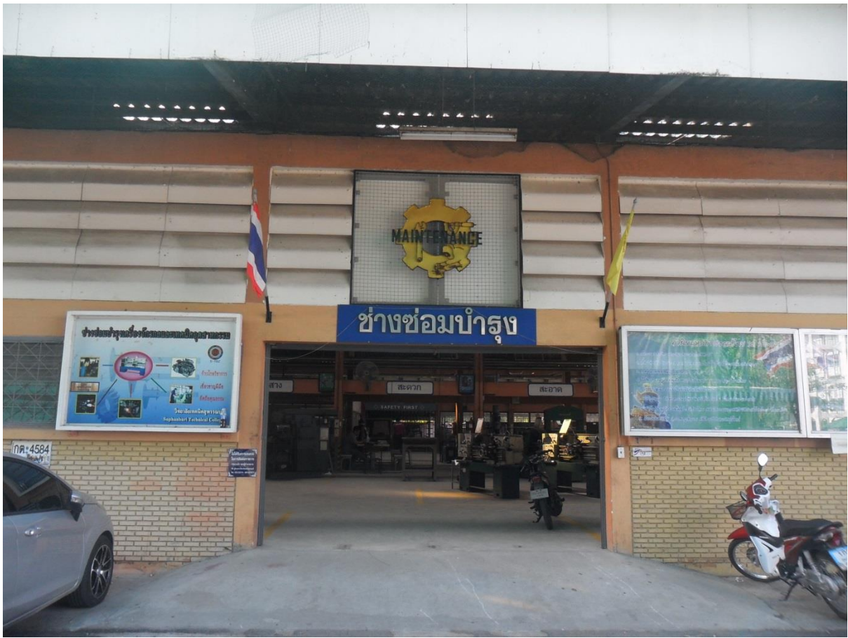
โรงปฏิบัติงานแผนกช่างซ่อมบำรุง
