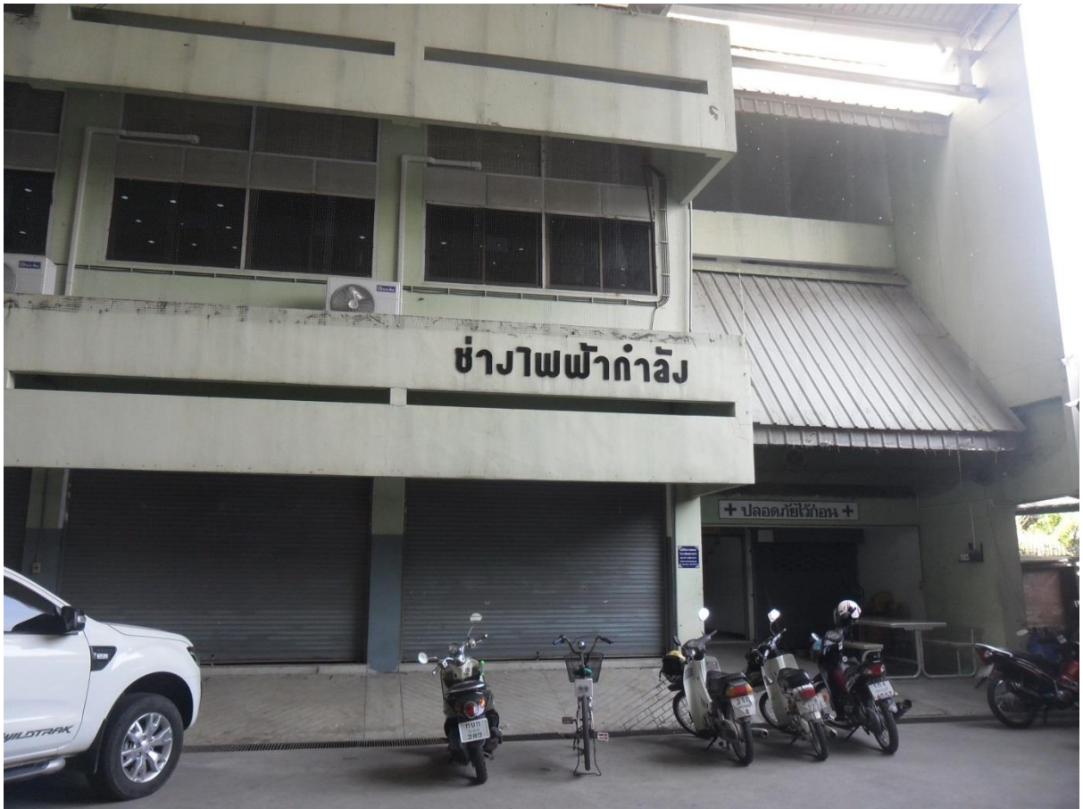
อาคารเรียนแผนกช่างไฟฟ้ากำลัง
