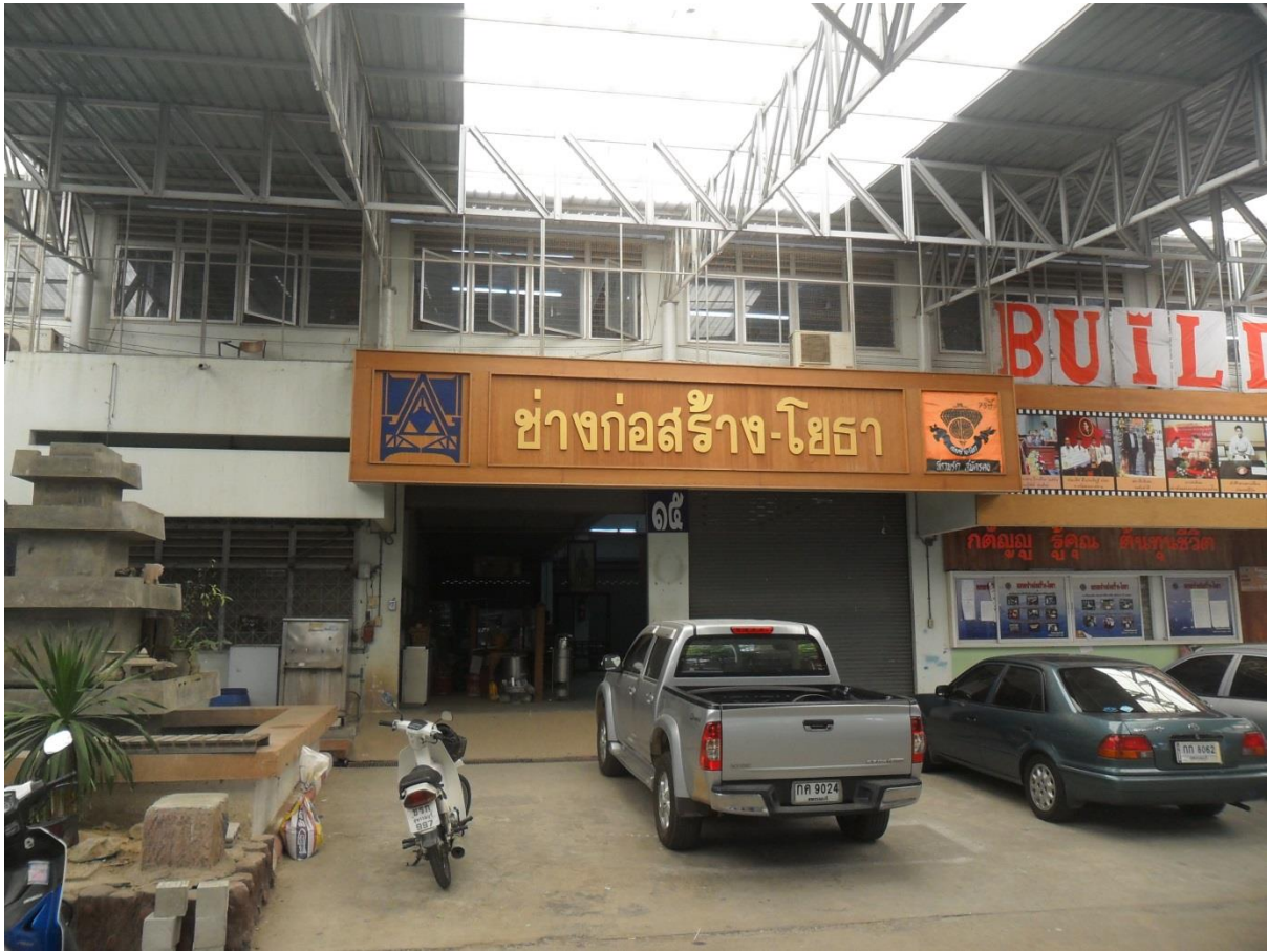
โรงฝึกปฏิบัติงานช่างก่อสร้าง-โยธา
